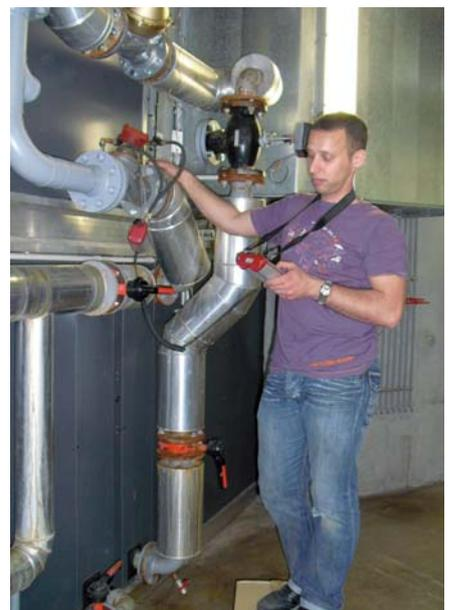
Le réglage des régulateurs permet de garantir l'obtention des débits et de diagnostiquer éventuellement des problèmes...
